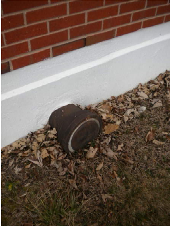
Photo D1: existing 8” pipe
